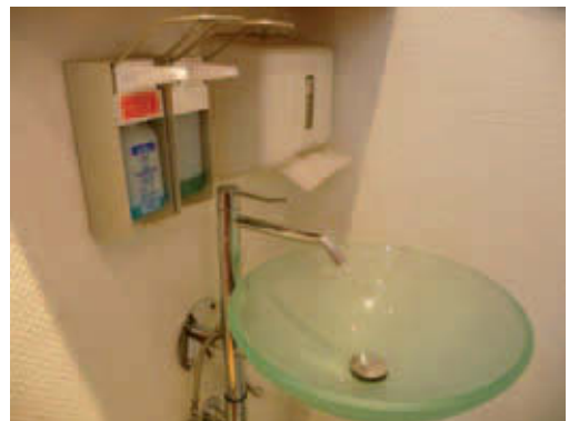
Abb. 4.1 Für Tätigkeiten der Schutzstufe 2 benötigen Sie Waschtisch-Armaturen, die ohne Handberührung bedienbar sind. (Gabriele Müller, Heidelberg)
